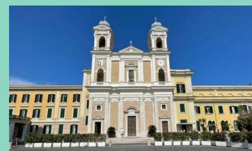
Chiesa Centrale UCSC
